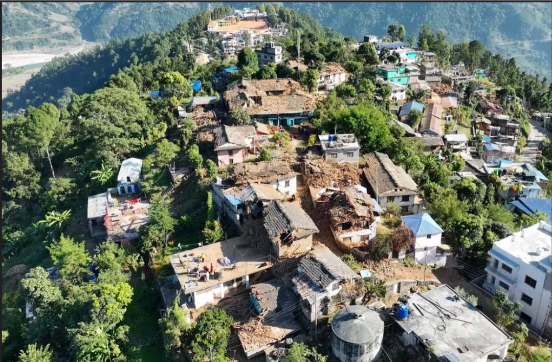
भूकम्पबाट भत्किएको घर निर्माणको प्रसाङ्गमा : विसं २०८० कात्तिक १७ गतेको भूकम्पबाट भत्किएको भेरी नगरपालिका-३ स्थित माथिल्लो थाप्लेको बस्ती। सरकारबाट प्राप्त हुने रकमबाट घर पूर्ण निर्माण गर्ने पखाङ्गमा यहाँका सर्वसाधारणहरू रहेका छन्। तस्वीर: रासस
