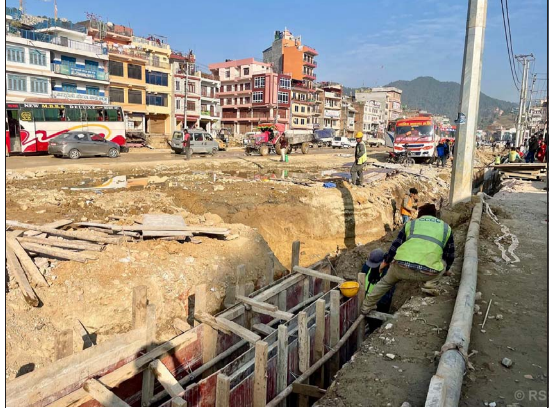
नाला निर्माण गरिदै: मुग्लिन-पोखरा सडक विस्तार अन्तर्गत तनहुँको व्यास नगरपालिका-३ मुख्यचोकमा नाला निर्माण गरिदै। राजमार्ग विस्तारका लागि दमौली खण्डमा यतिबेला धमाधम काम भइरहेको छ। तस्बिर: कृष्ण न्यौपाने/रासस
