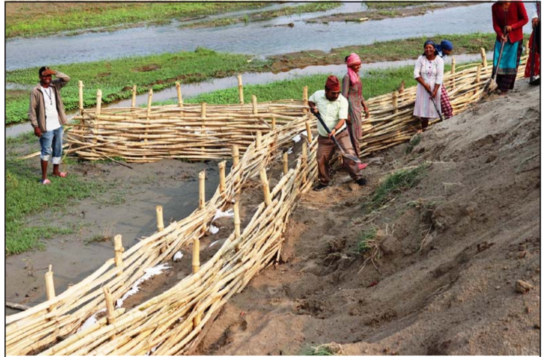
जैविक तटबन्ध निर्माण: कञ्चनपुरको शुक्लाफाँटा नगरपालिका-११ कलुवापुरस्थित सनबोरा नदीले पुऱ्याएको भूक्षय रोक्न जैविक तटबन्ध निर्माण कार्य गर्दै स्थानीय। कम लागतमा निर्माण हुने र भूक्षय रोक्नका लागि प्रभावकारी हुँदा वडा कार्यालयको बजेटमा स्थानीयले झन्डै चार सय मिटर लामो जैविक तटबन्ध निर्माण गरिरहेका छन्। तस्वीर: राजेन्द्रप्रसाद पनेरु/रासस
