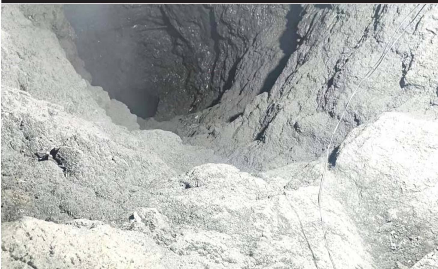
ठूलोखोला जलविद्युत् आयोजनाको सर्ज साफ्ट ब्रेक थ्रु म्याग्दीको रघुगङ्गा गाउँपालिका-८ मा निर्माणाधीन २१.३ मेगावाट क्षमताको ठूलोखोला जलविद्युत् आयोजनाको मुख्य सुरङसँग जोडिएको 'सर्ज साफ्ट'। संयुक्त ऊर्जा लिमिटेड प्रवर्द्धक रहेको ठूलोखोलाको सुरमा भन्ने ठाउँमा ४३.३६ मिटर गहिरो सुरङ बनाएर मुख्य सुरङसँग जोड्ने कार्य गराइति सम्पन्न भएको छ। तस्बिर: सन्तोष गौतम/रासस
