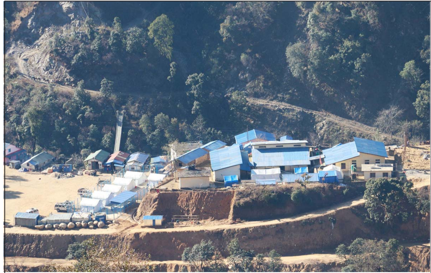
टेन्ट जडान गरेर अस्पताल सञ्चालन: बारेकोट गाउँपालिकाको लिम्सास्थित १० शय्याको प्राथमिक अस्पताल बसपाकमा टेन्ट जडान गरेर सञ्चालन हुँदै। भूकम्पका कारण स्वास्थ्य संस्थामा अति भएपछि टेन्टमाफर्त जाँच, उपचारदेखि सबै खालका कार्य हुँदै आएका छन्। तस्बिर: हेमन्त केसी/रासस
