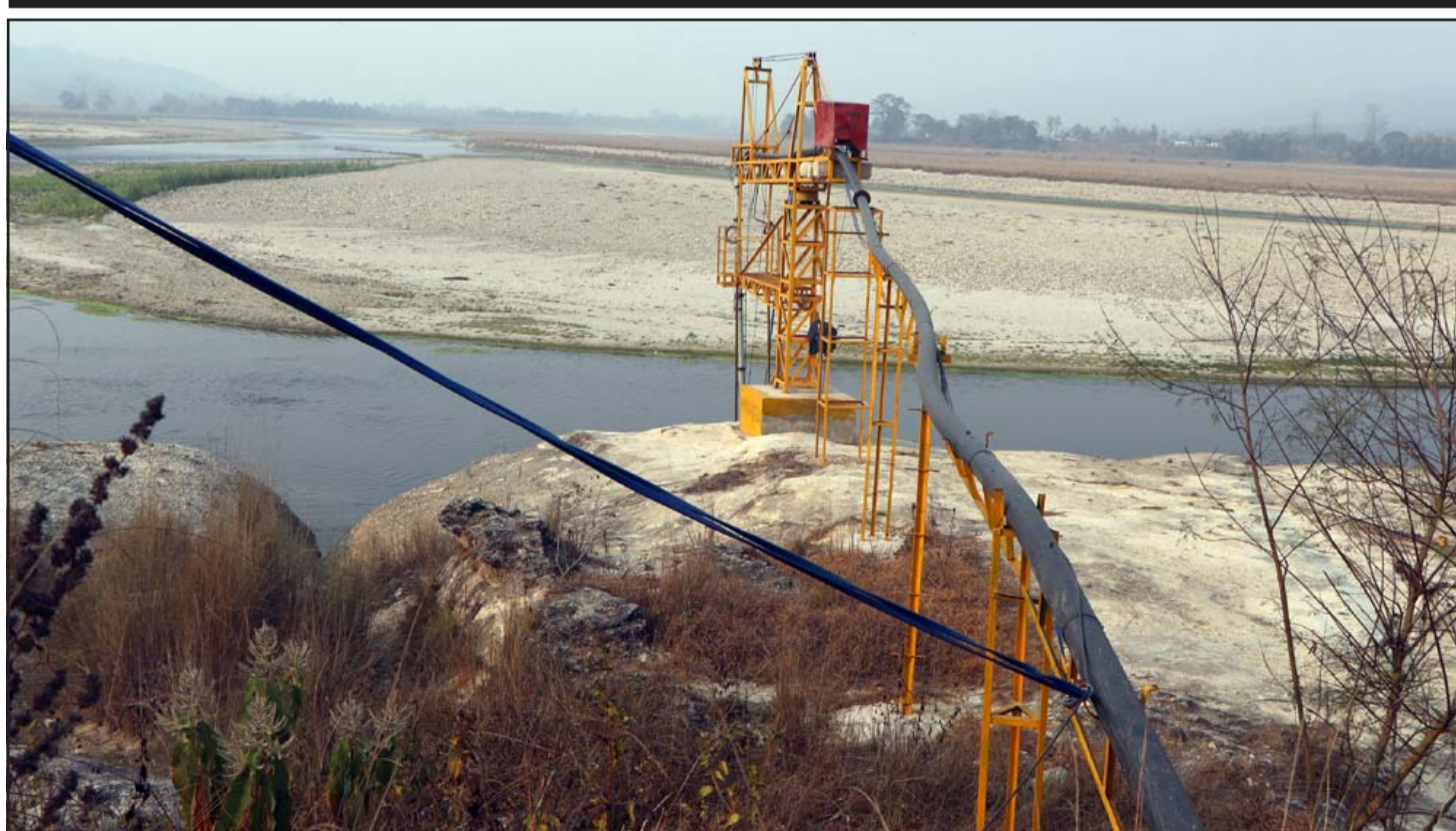
क्रेन लिफ्ट सिंचाइ आयोजना: चितवन भूमिगत संयोजनात्मक जल सिंचाइ आयोजनाले मकवानपुरको बागमती गाउँपालिका वडा नं २ राईगाउँस्थित बागमती नदीमा निर्माण गरेको क्रेन लिफ्ट सिंचाइ आयोजना । आयोजनाबाट यस क्षेत्रको सुख्खा जमीन सिञ्चित भएपछि स्थानीयवासी खुशी छन् ।
