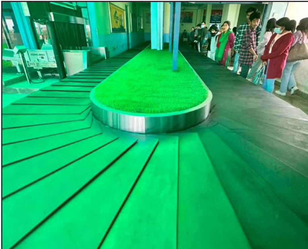
“कन्भेयर बेल्ट” सञ्चालन: नेपालगञ्ज विमानस्थलको आगमन कक्षामा अत्याधुनिक “ब्याजेट हँडलिंग सिस्टम” अन्तर्गत सञ्चालनमा ल्याएका “कन्भेयर बेल्ट” प्रणाली । तस्वीर : रासस
