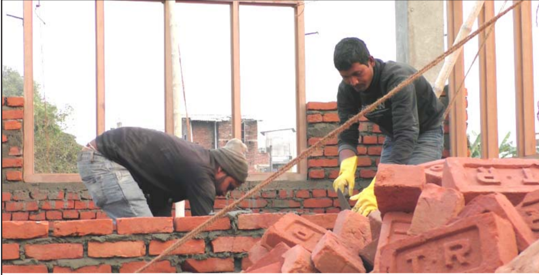
रोडा, गिट्टी, बालुवाको अभाव भएपछि भवन, सडक निर्माणलगायत विकास पूर्वाधारको काम ठप्प भएको छ । तस्वीर: जीतलाल श्रेष्ठ
