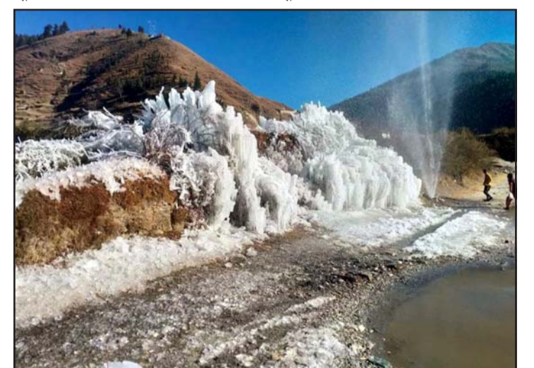
चन्दननाथ नगरपालिका-१ जुम्ला विमानस्थलनजीकै पाइप फुट्टा निस्केको पानीको फोहरा खसेको क्षेत्रमा चीसोले सेताममे बनेको बरफ। तस्वीर: रासस
