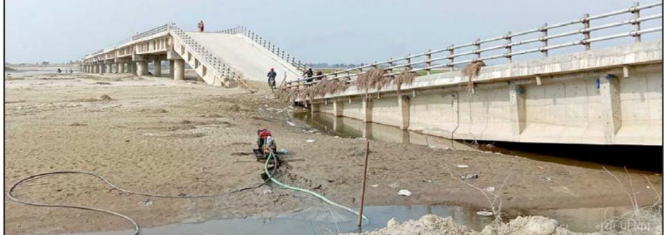
पुल निर्माण अलपत्र पार्ने निर्माण व्यवसायीलाई कारबाही गरिने भएको छ । सो पुल निर्माणको क्रममा एक वर्षअघि भौँचिएको थियो । उक्त पुल निर्माणको क्रममा २०७८ असारमा आएको बाढीले जग भासिन गई क्षतिग्रस्त भएको हो । त्यसपछि आयोजनाले निर्माण व्यवसायीलाई पटकपटक ताकेता गर्दासमेत हालसम्म पुनर्निर्माण गर्न अटेरी गरेको आरोप छ ।
