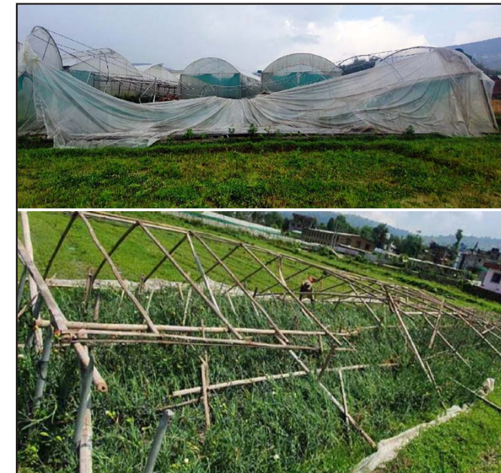
हावाहुरीले फूल र टनेलमा क्षति: बुधवार आएको हावाहुरीले क्षति पुऱ्याएको भक्तपुरको चाँगुनारायण नगरपालिका-८, बागेश्वरीको एभरग्रीन फ्लोरा एन्ड एग्रिकल्चर फार्ममा बाँसद्वारा निर्मित कार्नेसन फूलको टनेल । हावाहुरीका कारण फार्ममा रहेको फूल र टनेल नष्ट गर्दा ३ तीन लाख बराबरको क्षति भएको कृषक बताउँछन् । तस्वीर: रासस
