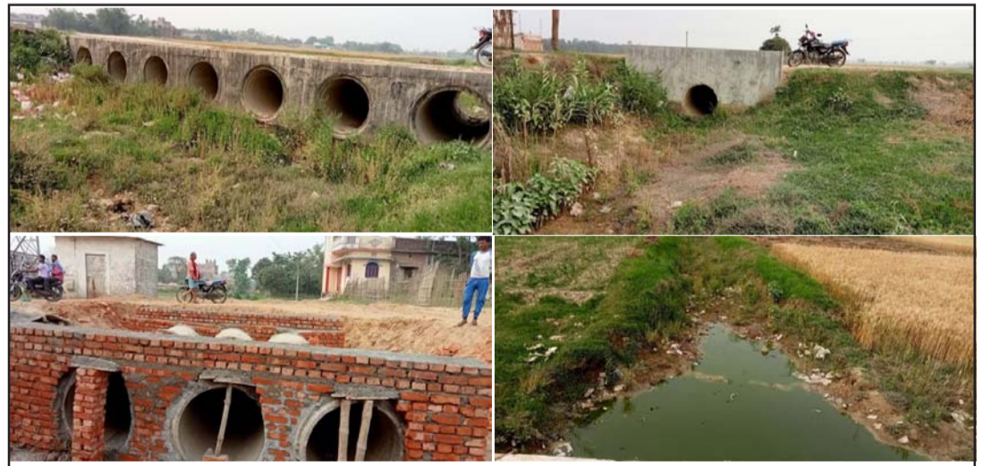
छिपहरमाई गाउँपालिकाको सबैठवा-जयमङ्गलापुर सडकखण्डमा जडान गरिएको ह्युमपाइप । तस्वीर: प्रतीक
