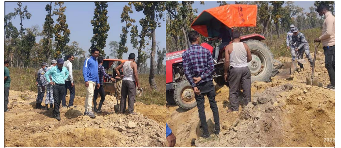
गुम्बा निर्माणस्थलमा खनिएको खाल्डो पुढै सुरक्षाकर्मी। तस्वीर: प्रतीक
