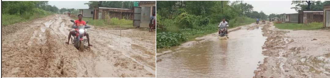
छिपहरमाई गाउँपालिका अन्तर्गत भिस्वादेखि तुलसीबर्वा जाने बाटोको दृश्य । सडक निर्माणका लागि ठेकेदारले माटो खसाउने काम मात्र गरेकोले वर्षायाममा हिलाम्य र घाम लागेपछि धूलो उडेर यो सडकबाट आवतजावत गर्न यात्रीहरूलाई निकै समस्या हुने गरेको छ । अहिले पानी परेपछि यो सडकखण्डबाट सवारीसाधन सञ्चालन हुन सकेको छैन । केही सवारीसाधन सञ्चालन भएपनि हिलोको कारण निकै कष्ट झेल्नुपरेको छ । तस्वीर: सुप्रीव साह
