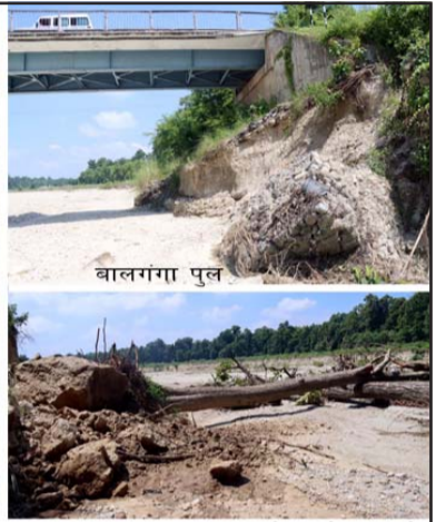
अधिल्ला वर्षहरूमा बालगङ्गा खोलामा अत्यधिक नदीजन्य पदार्थ उत्खनन भएपछि खोला किनारको वन क्षेत्र तीव्र कटानसँगै दर्जनौं रूख ढल्यौं, पुल पनि उच्च जोखिममा परेको छ। तस्वीर: जीतलाल श्रेष्ठ
