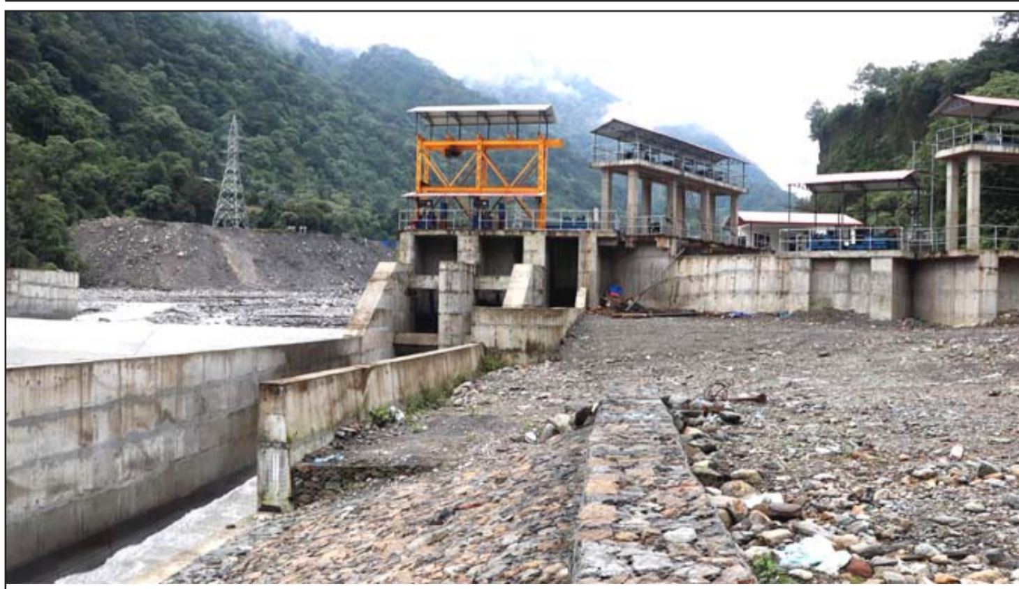
सेती नदी जलविद्युत् आयोजनाको बाँध: कास्कीको माछापुच्छ्रे गाउँपालिका-२ सार्दीखोलाको भराभरीमा रहेको निर्माणाधीन २५ मेगावाट क्षमताको सेती नदी जलविद्युत् आयोजनाको बाँध। आयोजनको मेशिनरी परीक्षण भइरहेकाले यही असोजभित्रमा व्यावसायिक विद्युत् उत्पादनको तयारी गरिएको छ। तस्बिर: कृष्ण दवाडी/रासस
