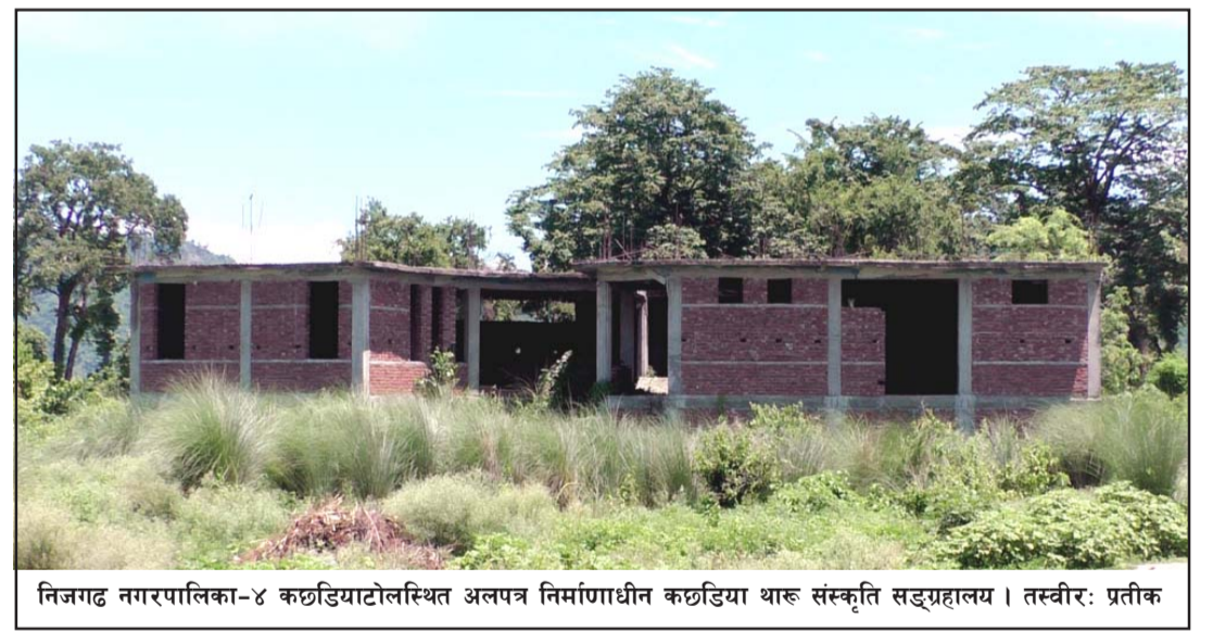
निजगढ नगरपालिका-४ कछडियाटोलस्थित अलपत्र निर्माणाधीन कछडिया थारू संस्कृति सङ्ग्रहालय । तस्वीरः प्रतीक
