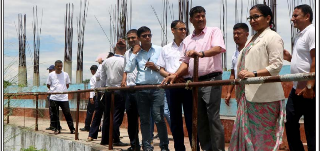
गौरवको आयोजनामा समेटिएको चितवनको भरतपुर महानगरपालिका-१५ स्थित गौतमबुद्ध अन्तर्राष्ट्रिय क्रिकेट रङ्गशालाको बिहीवार निरीक्षण गर्दै महानगर प्रमुख रेणु दाहाल महानगरका कर्मचारी, प्राविधिक र निर्माण कम्पनीका प्रतिनिधिहरू। निर्माण कम्पनी र महानगरले संयुक्तरूपमा उक्त रङ्गशाला स्थलगत निरीक्षण गरेपछि लगत्तै काम शुरू गर्ने तयारीमा छ। तस्वीर: सनद अधिकारी/ रासस
